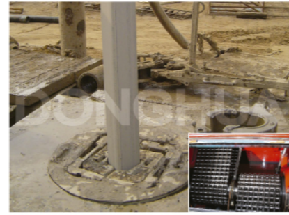
3. Bomba extracción de petróleo
